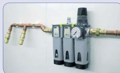
Montaż na ścianie
